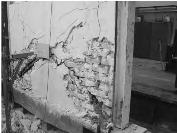
شکل ۱۳. نمایی بعد از آزمایش نمونه از طرف گچ‌کاری شده.
