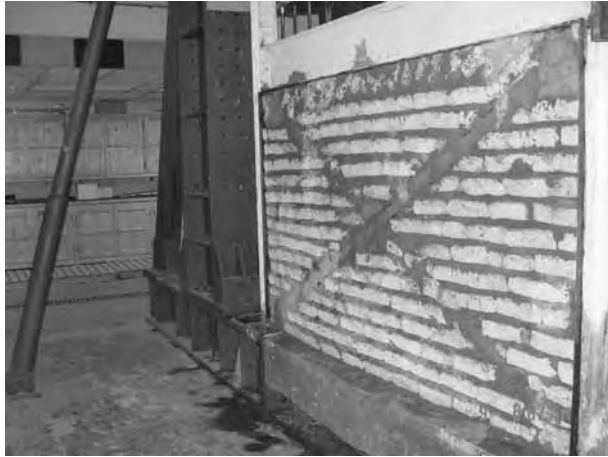
شکل ۱۱. نمایی از دیوار چینی داخل قاب قبل از نازک‌کاری.
